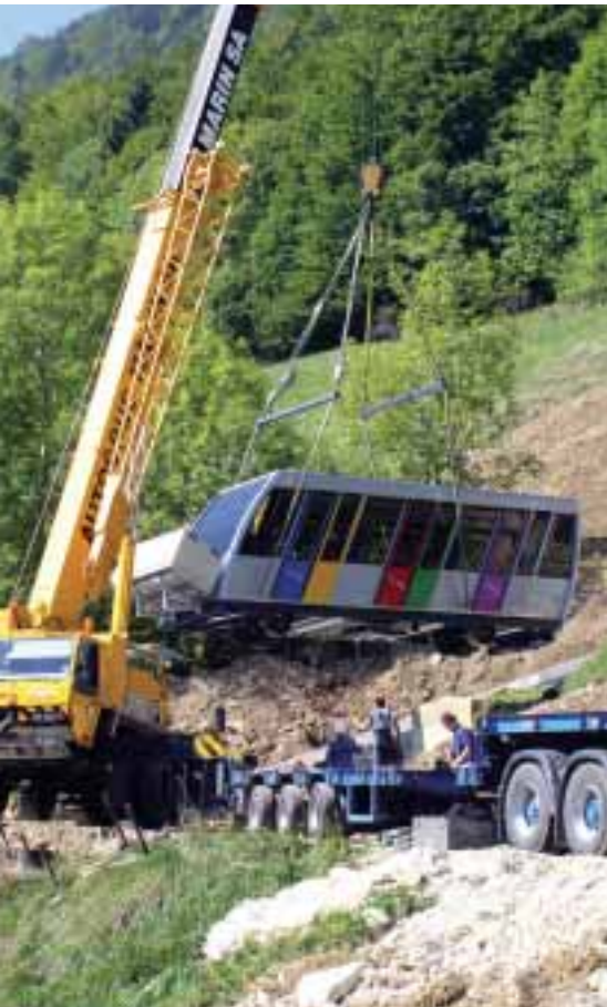
15 septembre 2003: montage de la nouvelle voiture
